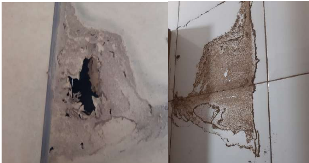
Figura 15: Dano causado por cupim de solo em móvel em contato com a parede
