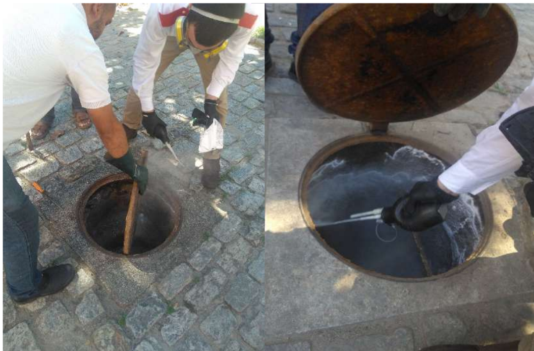
Figura 72: Abertura da caixa do esgoto, avaliação e colocação de pesticidas de controle
